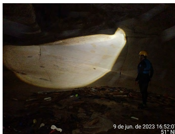
FOTO 93 – VISTA DO INTERIOR DA CAVIDADE FONTE: GEOPAC, 2024
