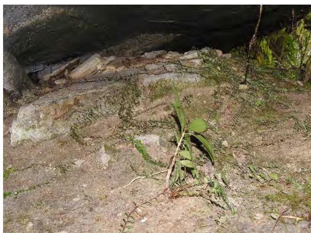
FOTO 180 – MATERIAL E DETRITOS VEGETAIS NO PISO FONTE: CONSERV, 2023
