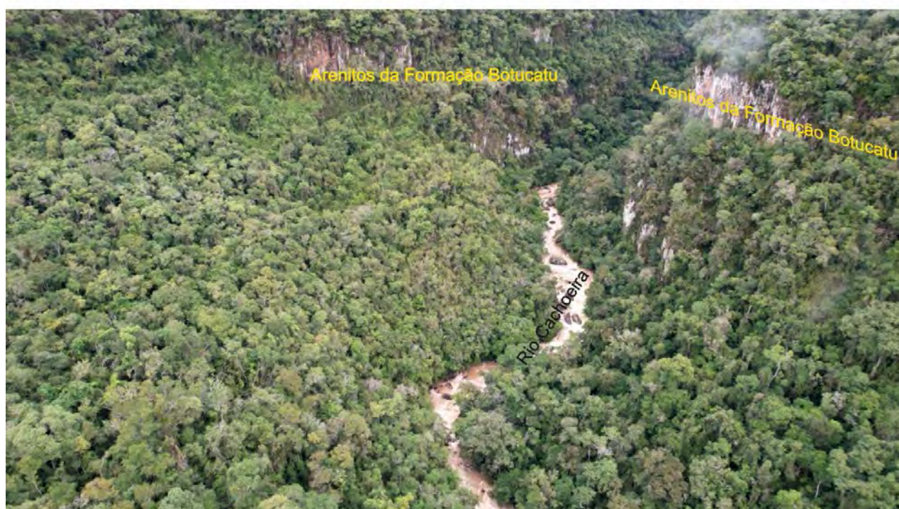
FOTO 201 - REGISTRO FOTOGRÁFICO POR DRONE DOS PAREDÕES ROCHOSOS NA ÁREA DE INFLUÊNCIA DA PCH PAREDINHA FONTE: GEOPAC, FÁBIO MANASSÉS, 2023
